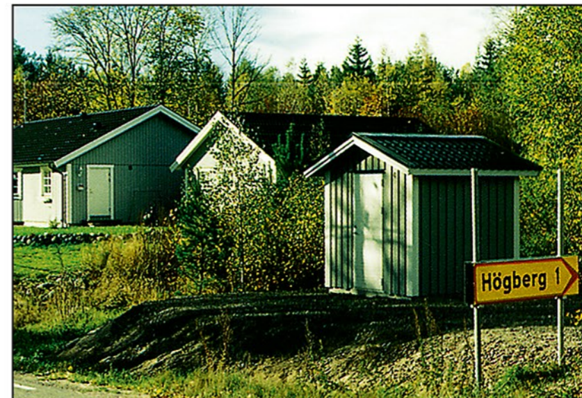
Pumpstation som smälter in i omgivande miljö.
